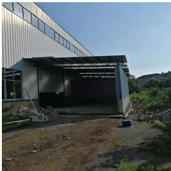
一般固废暂存间防风、防淋、防渗
