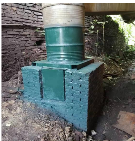
抛丸除尘排气筒底座密封
