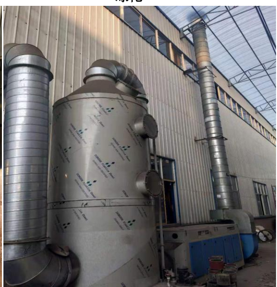
喷漆排气筒(UV光解)
