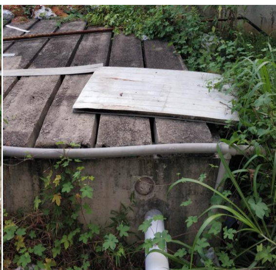
循环水池（事故应急池）
