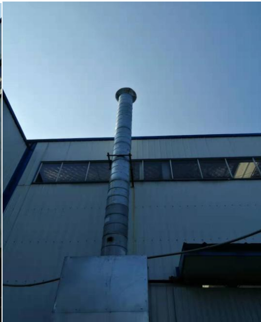
炼胶排气筒加高到 15m
