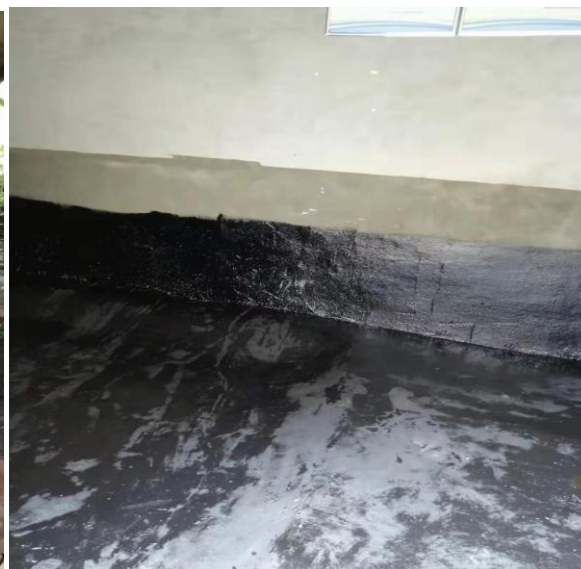
危废暂存间防渗
