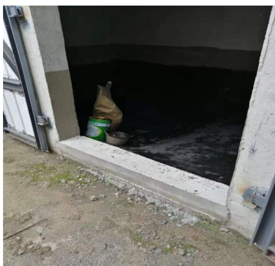
危废暂存间门槛
